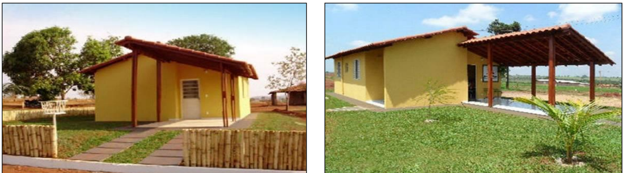
Figura 18- Ituiutaba (MG): Padrão arquitetônico das unidades habitacional Residencial Camilo Chaves (2010).
