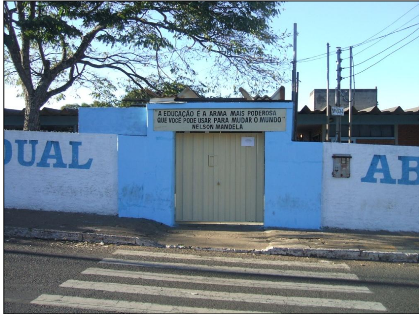
Foto 1 - Portão principal do Colégio Estadual “Abrahão André”, Catalão (GO) - jun/2011.
