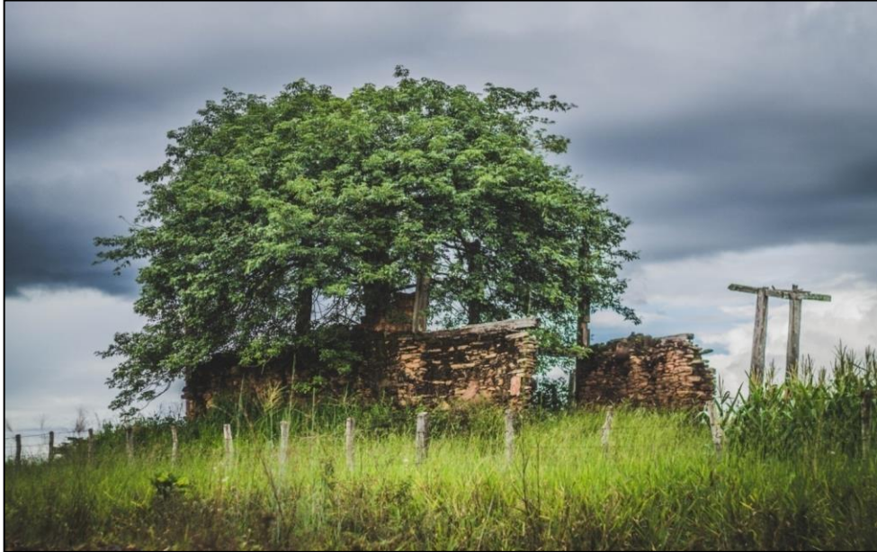
Foto 2 – Ruínas de Nossa Senhora d’Abadia – Três Ranchos (GO) (2017)
