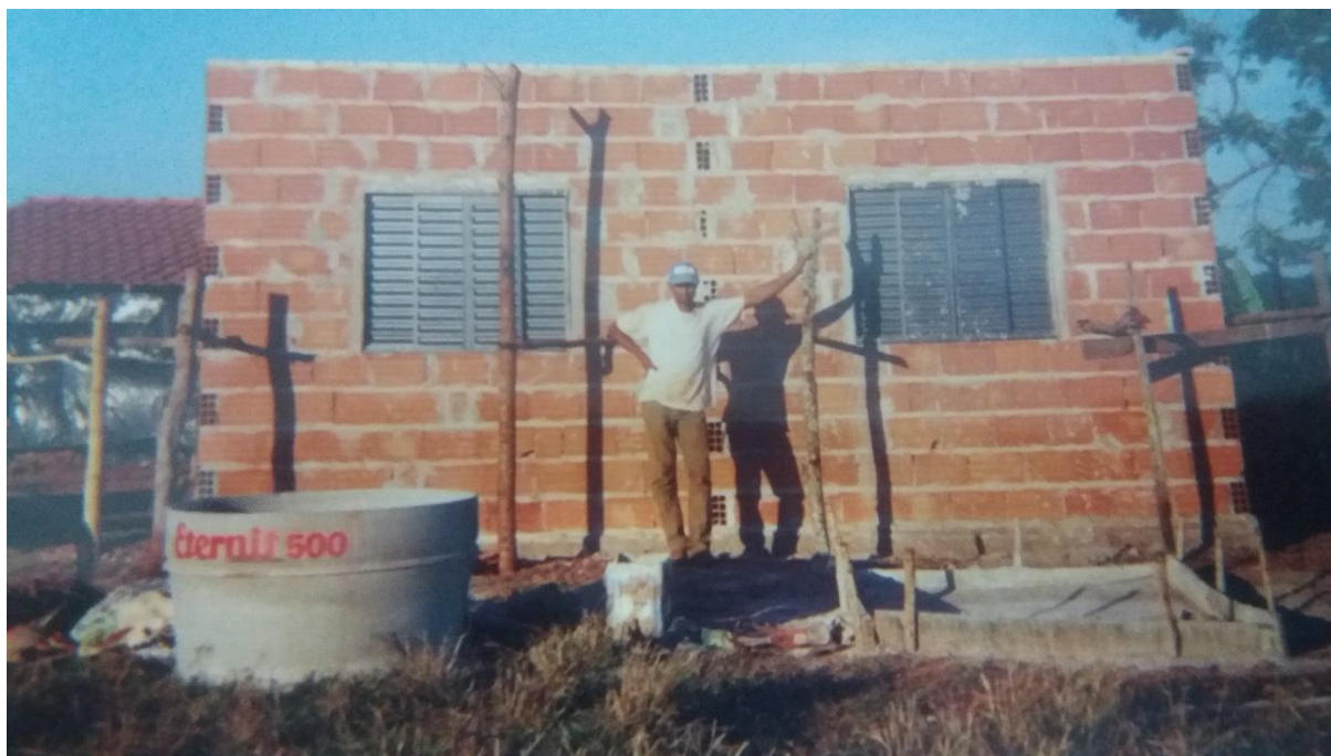
Foto 5 – PA Chico Mendes em Ituiutaba (MG): construção de residência – 2001.
