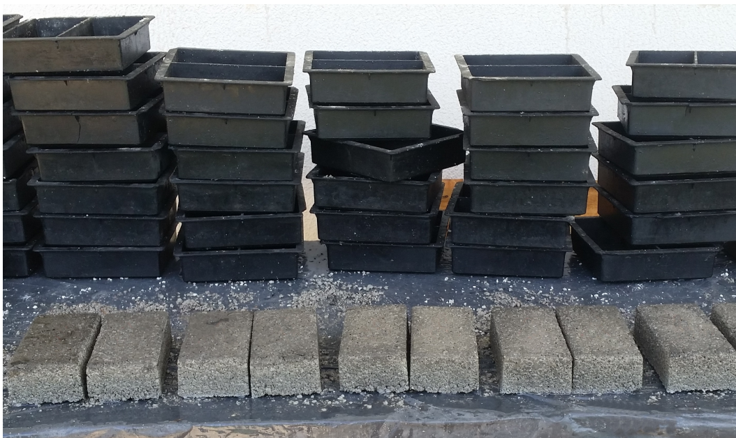
Figura 3.4 – Tijolos de concreto após a desmoldagem.
