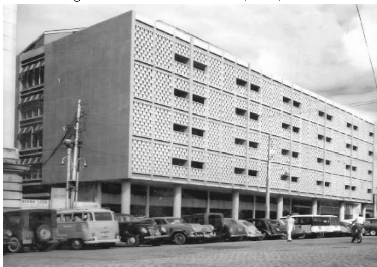
Figura 6 - Edifício Santo Antônio, 1963, Recife.
