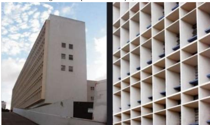
Figura 4 - Hospital da Restauração, 1951, Recife.
