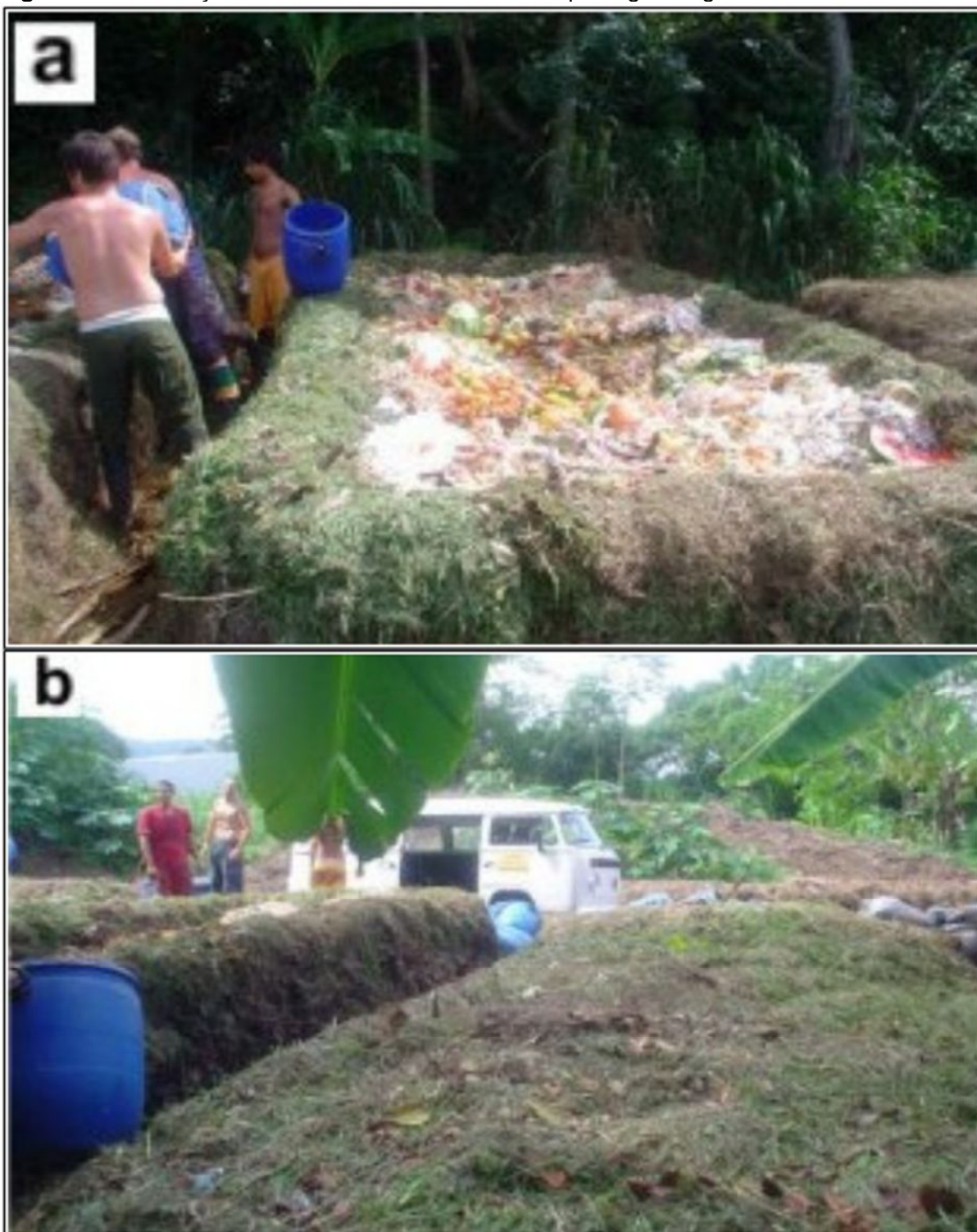
Figura 12: construção e conclusão das leiras de compostagem orgânica na UFSC.
